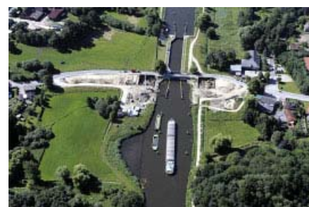
Bild 2. Luftbild Bauzustand der Kanalbrücke Berkenthin im Juli 2009 (Quelle: Echterhoff Bau-Gruppe, Niederlassung Hamburg)
